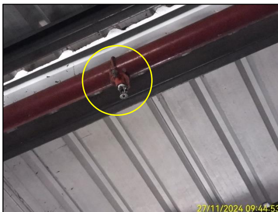
ภาพที่ 2.2-10 หัวฉีดพ่นน้ำแบบสเปรย์ในระบบ สายพาน
