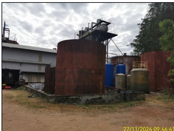
ภาพที่ 2.2-16 คันคอนกรีตล้อมรอบลานถ้ำน้ำมันเตา
