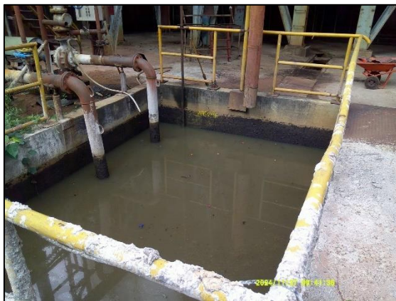
ภาพที่ 2.2-19 รางและบ่อรวบรวมน้ำทิ้งจากระบบ
