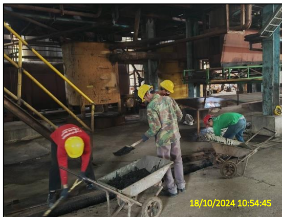
ภาพที่ 2.2-21 การขุดลอกตะกอนทำความสะอาด รางระบายน้ำ
