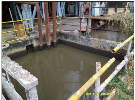
ภาพที่ 2.2-19 รางและบ่อรวบรวมน้ำทิ้งจากระบบ
